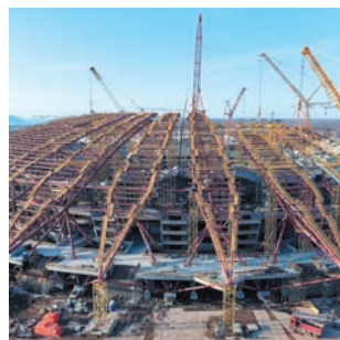
Монтаж металлоконструкций на стадионе «Самара Арена» планируется завершить в течение полутора месяцев
