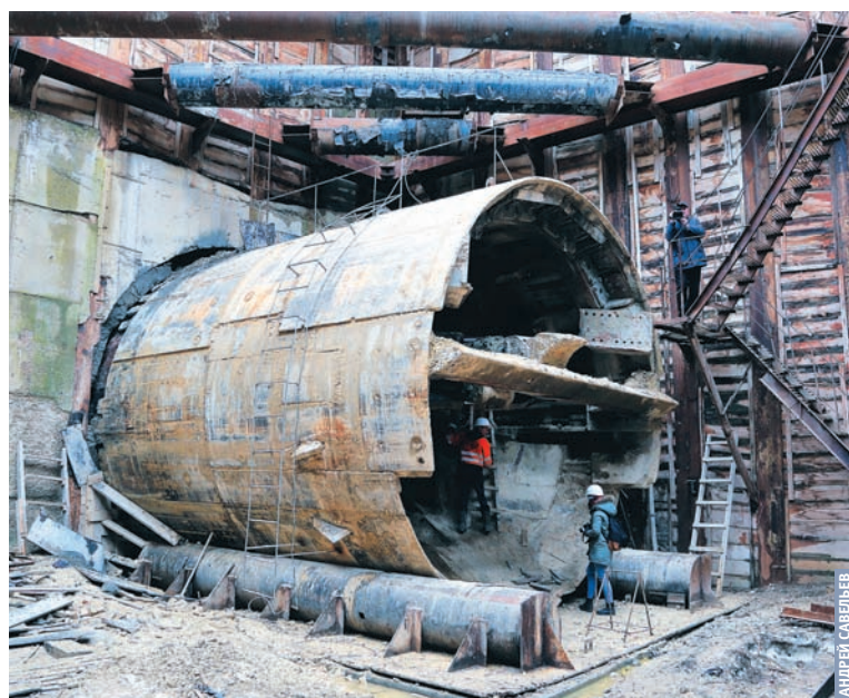
НА ДНЕ КОТЛОВАНА ЗАСТЫЛА НАПОЛОВИНУ ВЫРВАВШАЯСЯ ИЗ ЗЕМЛИ ГОРНОПРОХОДЧЕСКАЯ МАШИНА — ИМЕННО ОНА МЕТАЛЛИЧЕСКОЙ «ЛАПОЙ» КОПАЕТ ТОННЕЛИ САМАРСКОГО МЕТРО
